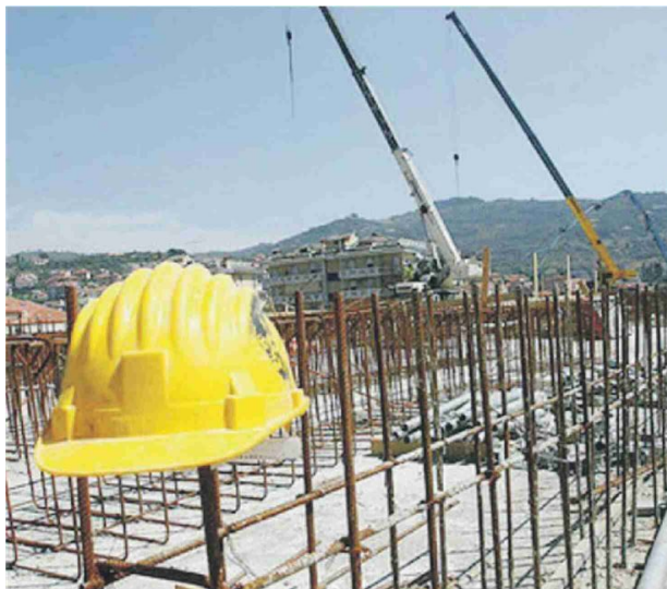
L'immagine di un cantiere edile
